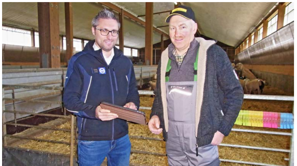
Tagesaktuelle Klimadaten, jederzeit von überall her abrufbar: Tobias Jäggle (li.), Vertriebsleiter Agrartechnik bei der Firma Lock Antriebstechnik, hat Jörg Schmid (re.) beim Einbau der vollautomatisierten Steuerung für die Be- und Entlüftung des gepachteten, kommunalen Schafstalles beraten.
